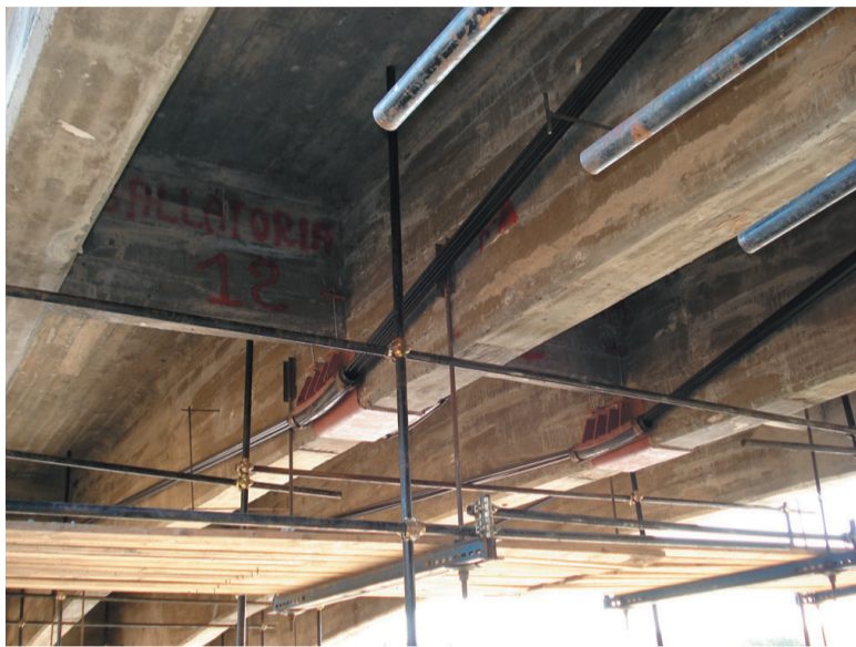
● Fig. 14 - I ballatoi per l'installazione delle selle di deviazione. ● Fig. 14 - The galleries for the installation of the deflection saddles.
