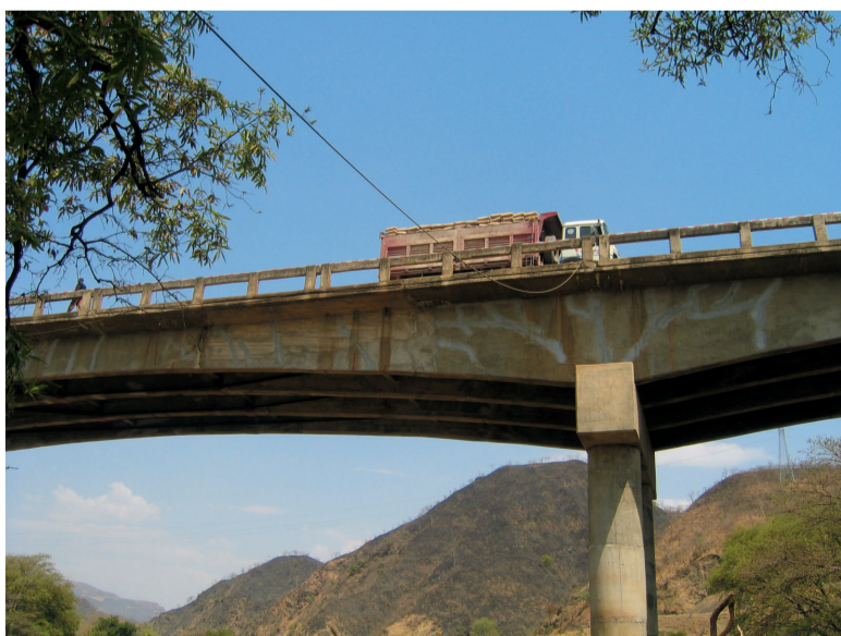
● Fig. 12 - Prospetto della trave con le fessure iniettate. ● Fig. 12 - View of the beam with the cracks grouted in.
