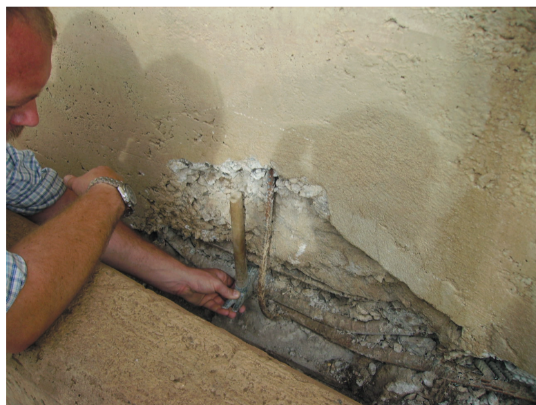
● Fig. 5 - Danneggiamento delle travi in corrispondenza della pila centrale per eccesso di compressione. ● Fig. 5 - Damage to the beams at the centre pier owing to excess compression.
