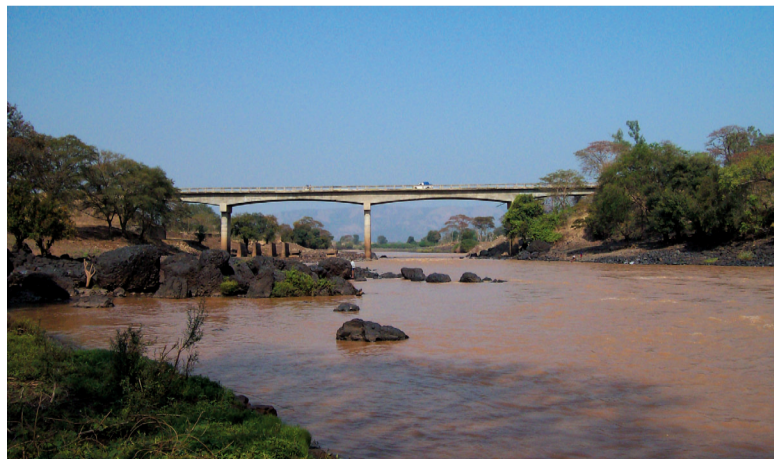
● Fig. 1 - Il ponte in c.a. sul Gibe. ● Fig. 1 - The r.c. bridge over the Gibe river.
