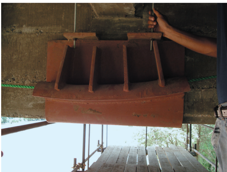
● Fig. 10 - Sella di deviazione in carpenteria metallica. ● Fig. 10 - Deflection saddle made of structural steel.
