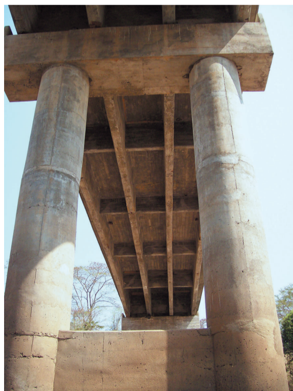
● Fig. 3 - Il ponte sul Gibe. ● Fig. 3 - The bridge over the Gibe river.
