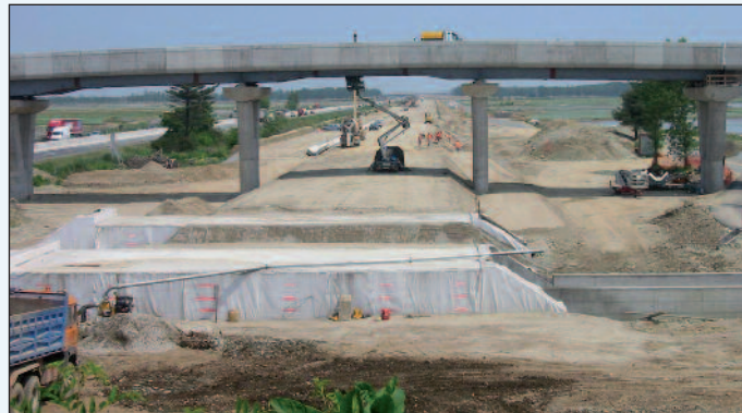
Figura 7 - Il sovrappasso sulla A4 e AC, Strada Comunale di Gargarengo nel comune di Vicolungo: in evidenza la campata di spessore ridotto sulla linea AC
