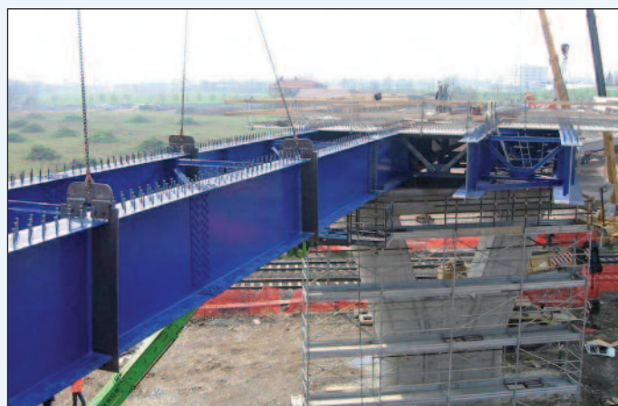
Figura 12 - Il cavalcavia obliquo S.P. Cebrosa sulla ferrovia storica TO-MI a Settimo Torinese, in fase di montaggio
