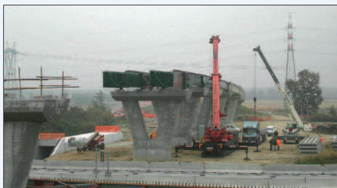
Figura 11 - Il cavalcavia in retto di Balocco-Formigliana a Balocco in fase di montaggio
