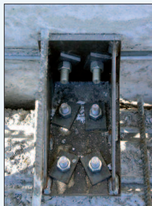
Figura 9 - Il dettaglio del sistema di aggancio predalle - veletta
