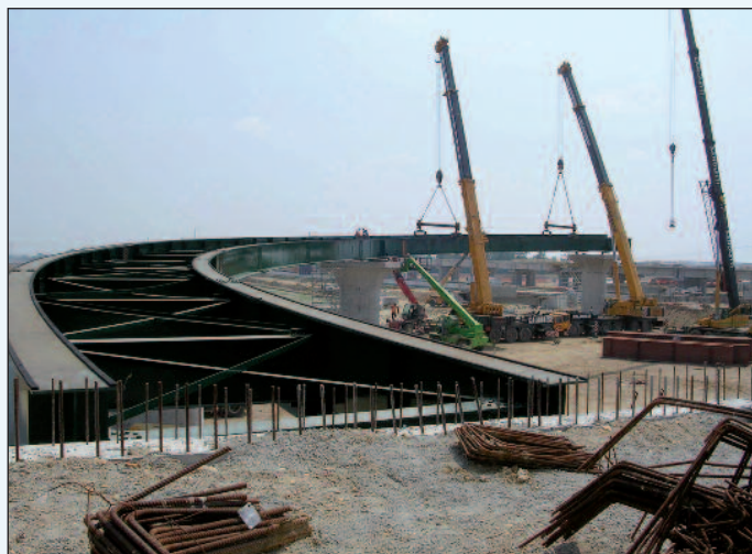
Figura 15 - Uno dei due cavalcavia dello svincolo di Carisio in costruzione
