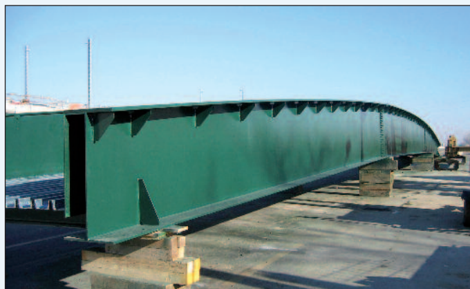
Figura 22 - La passerella di Pregnana assemblata e pronta per il varo
