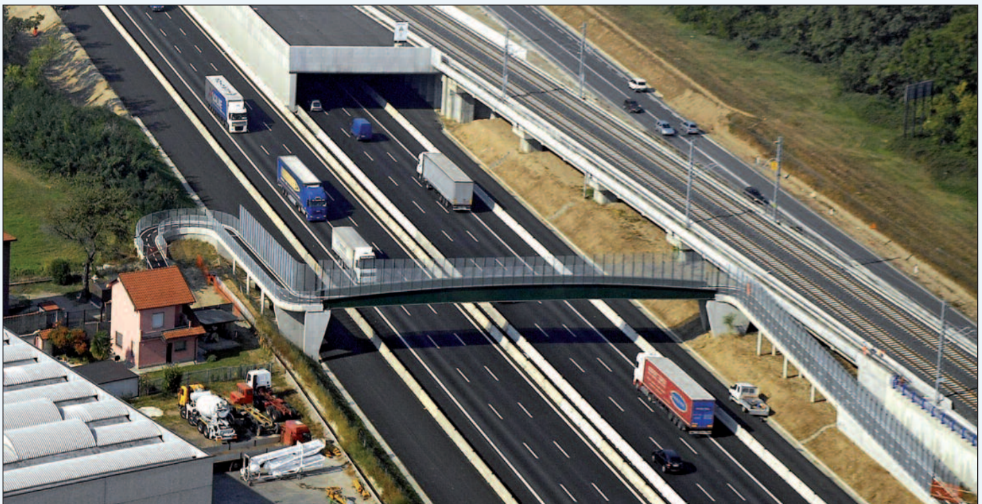
Figura 21 - La passerella di ciclo-pedonale di Pregnana in esercizio
