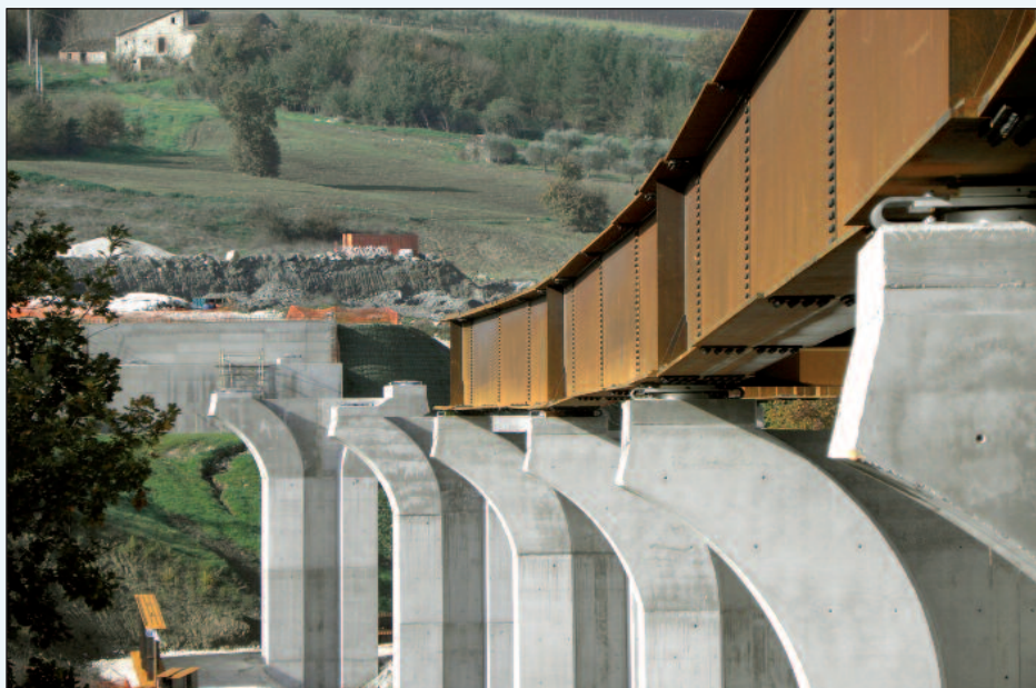
Figura 9 - Uno scorcio dei testa pila e dell'impalcato del Tammaro I con gli appoggi dotati di ritegni elasto-plastici
