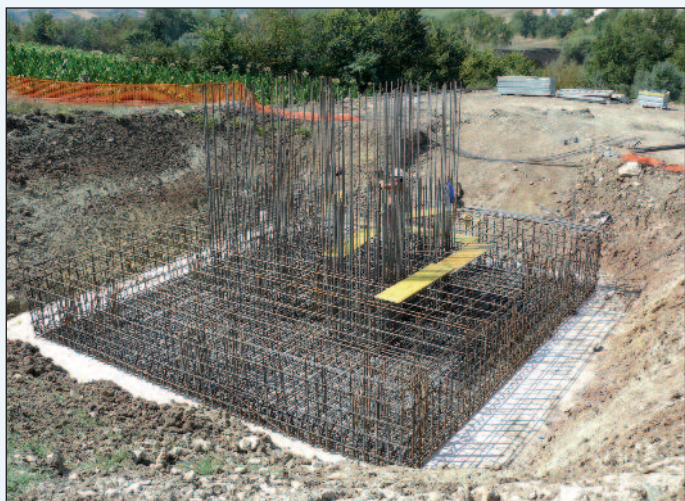
Figura 7 - Un plinto a nove pali del Tammaro II
