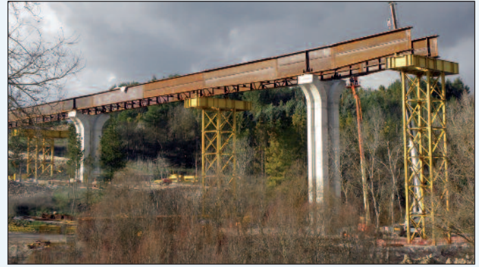
Figura 13 - Il montaggio della campata sul Tammaro
