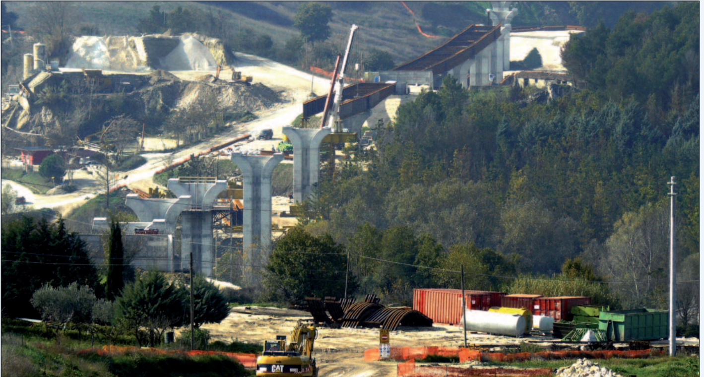
Figura 2 - Una panoramica del Tammaro I e del Tammaro II (sullo sfondo). I due viadotti hanno le spalle poste a poche decine di metri
