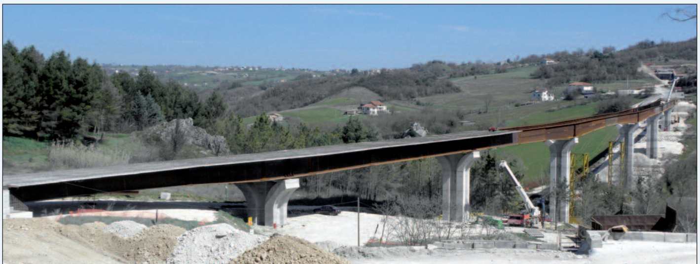
Figura 15 - Il montaggio della carpenteria metallica e la posa in opera delle predalles avanzano di pari passo sul Tammaro II
