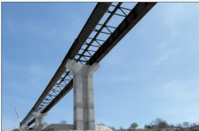
Figura 4 - La pila e il pulvino del Tamaro II
