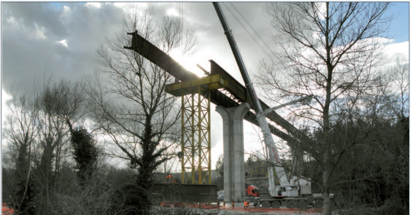
Figura 12 - Il montaggio della campata sul Tammaro
