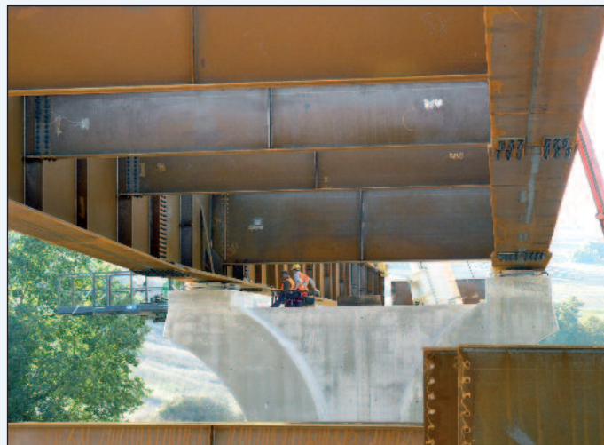
Figura 8 - Un dettaglio dell'impalcato e dei traversi del tammaro I
