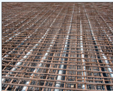
Figura 12 - La fase di costruzione dell'impalcato OA2. In evidenza, il tracciato delle guaine per i cavi di precompressione
