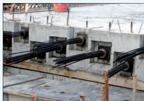
Figura 10 - Un dettaglio delle teste d'ancoraggio dell'impalcato da 16 m (OA2)
