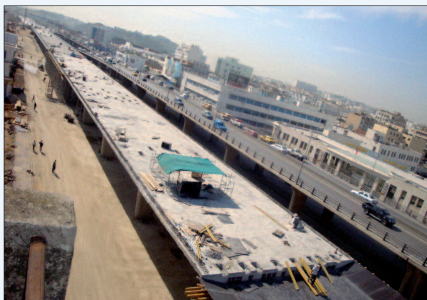
Figura 5 - L'impalcato da 16 m (OA2) in costruzione
