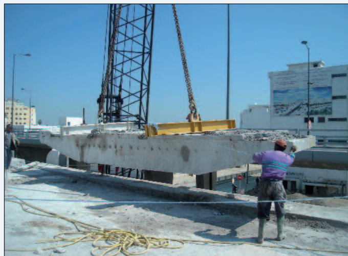
Figura 6 - La demolizione della vecchia rampa dell'impalcato esistente (OA1)
