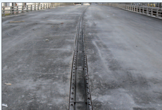
Figura 16 - Una vista del giunto longitudinale posto in asse carreggiata
