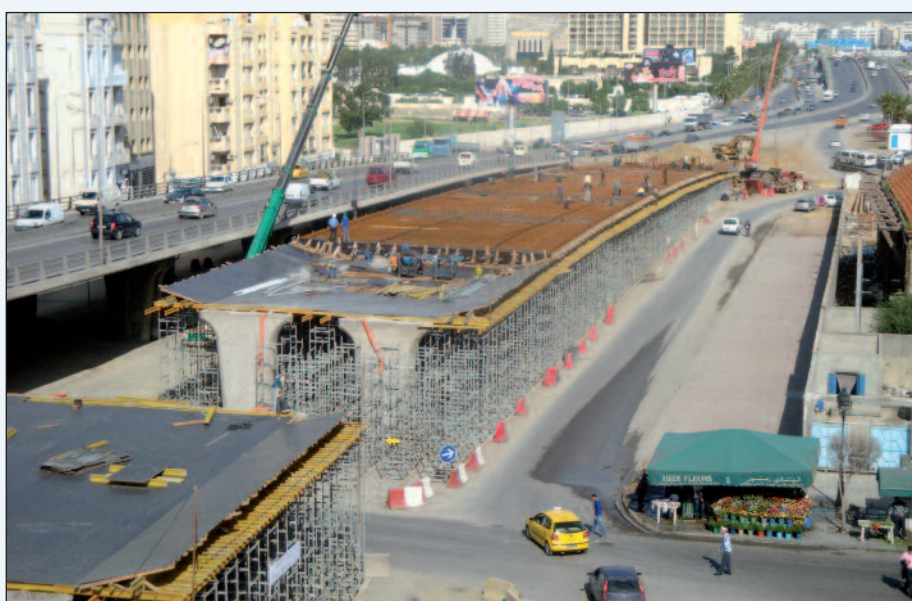
Figura 8 - L'impalcato da 16 m (OA2) in costruzione
