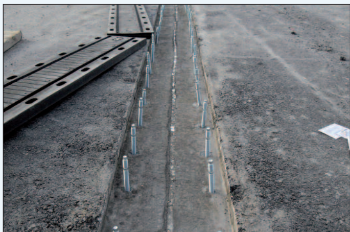
Figura 18 - Un dettaglio di una fase della disposizione del giunto longitudinale. Si notano le barre filettate per il fissaggio del giunto agli impalcati
