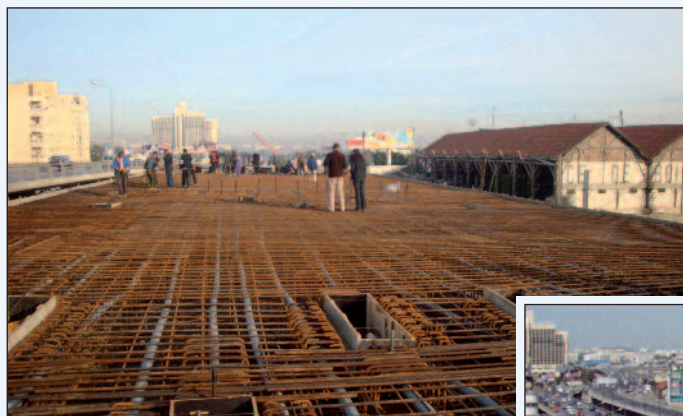
Figura 11 - La fase di costruzione dell'impalcato OA2. In primo piano, le casserature delle nicchie per la tesatura dei cavi all'estradosso
