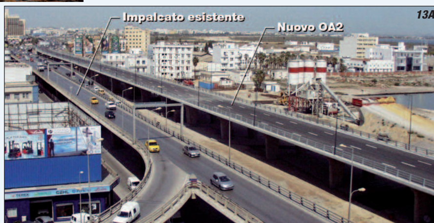
Figura 11 - La fase di costruzione dell'impalcato OA2. In primo piano, le casserature delle nicchie per la tesatura dei cavi all'estradosso
