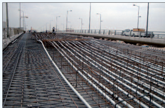
Figura 14 - La fase di costruzione dell'impalcato OA1 in affiancamento all'esistente. In evidenza il tracciato delle guaine per i cavi di precompressione
