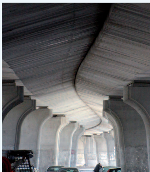
Figura 4 - I due impalcati esistenti in affiancamento
