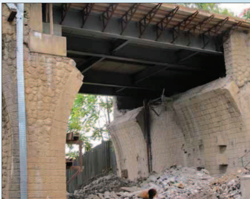
Рис. 9. Буферный пролет между устоем и промежуточной опорой 1
