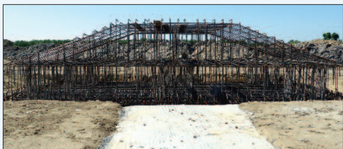
6. L'armatura di un plinto di fondazione delle antenne
