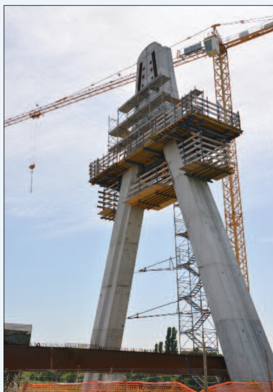
4. Un'antenna quasi ultimata
