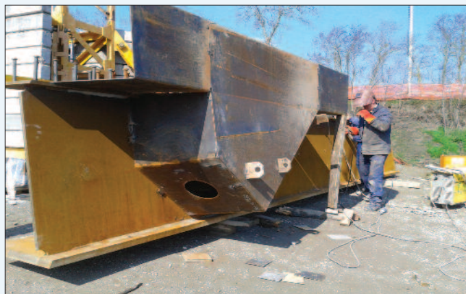
7. Dettagli degli ancoraggi dell'impalcato
