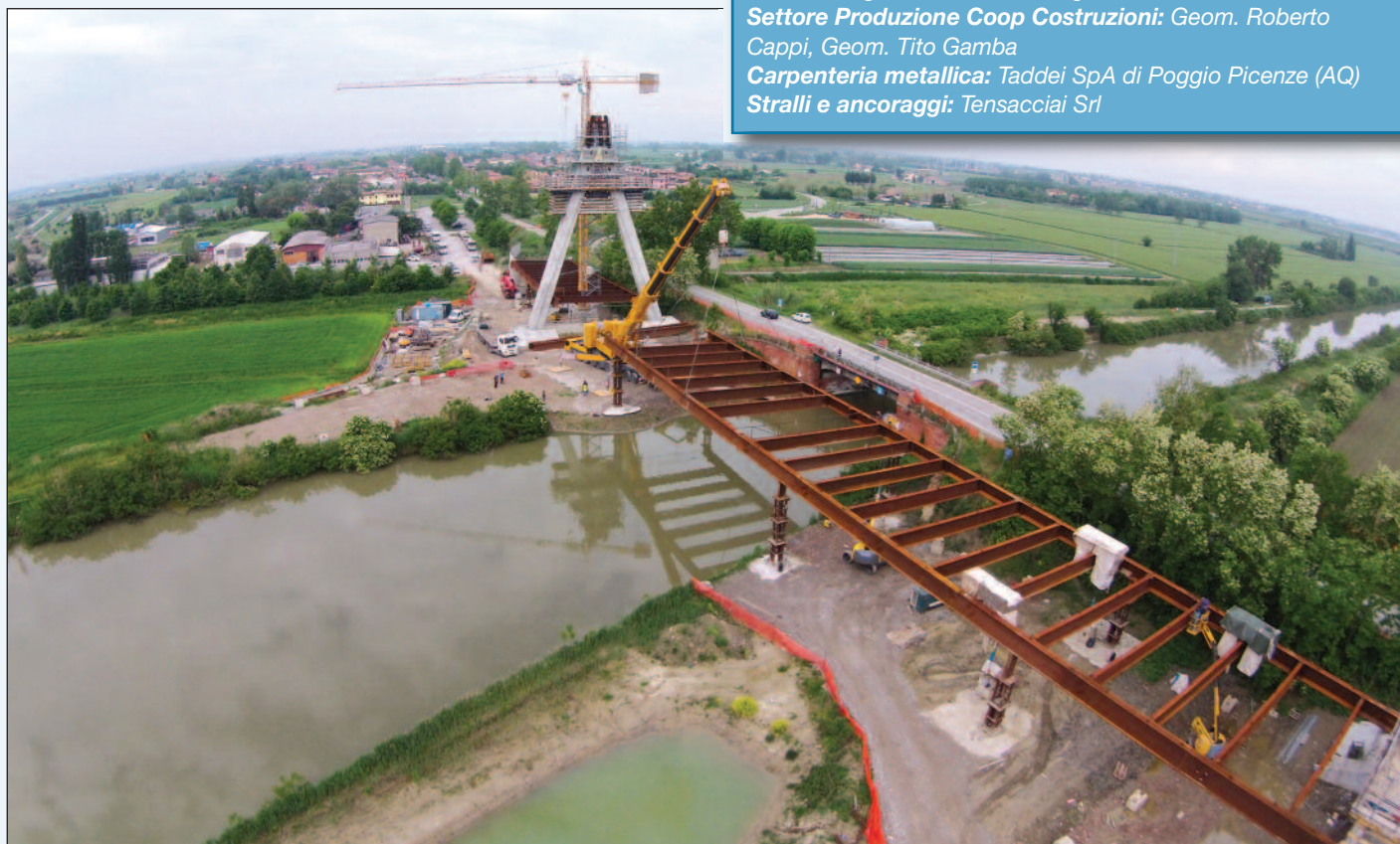
9. Il varo del concio centrale
