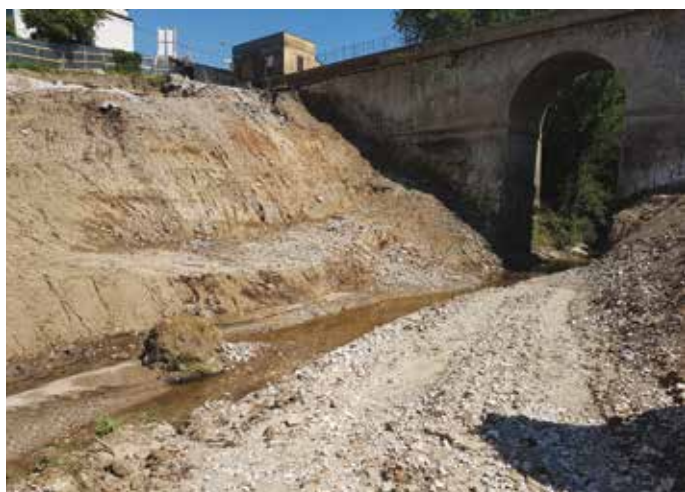
3. Il ponte settecentesco sul fosso dell'Empiglione
