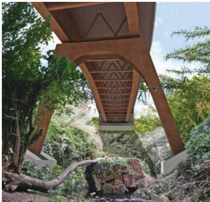
6. Un rendering della soluzione vincente con la pila a cavalletto
